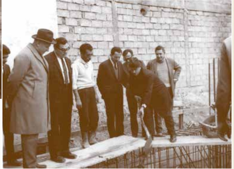
1970 yılı, 1999 depreminde yıkılan ATSO hizmet binasının temel atma töreni
